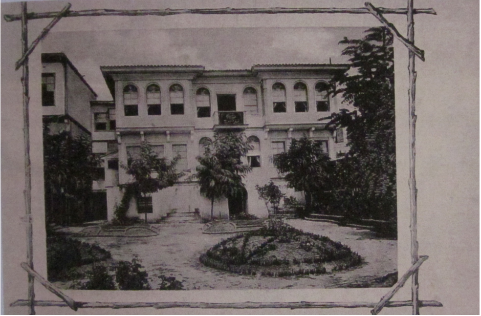
Selanik'teki Fevziye Mektebi Kızlar Bölümü Binası
